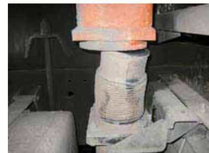
«Гофра» для подачи отработанных газов к днищу кузова несоосна
